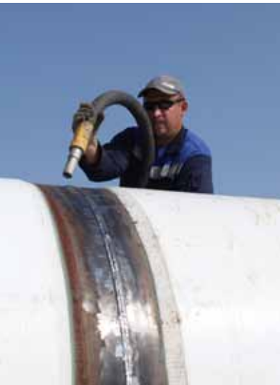
Слева-направо: Пескоструйная обработка зоны стыка
