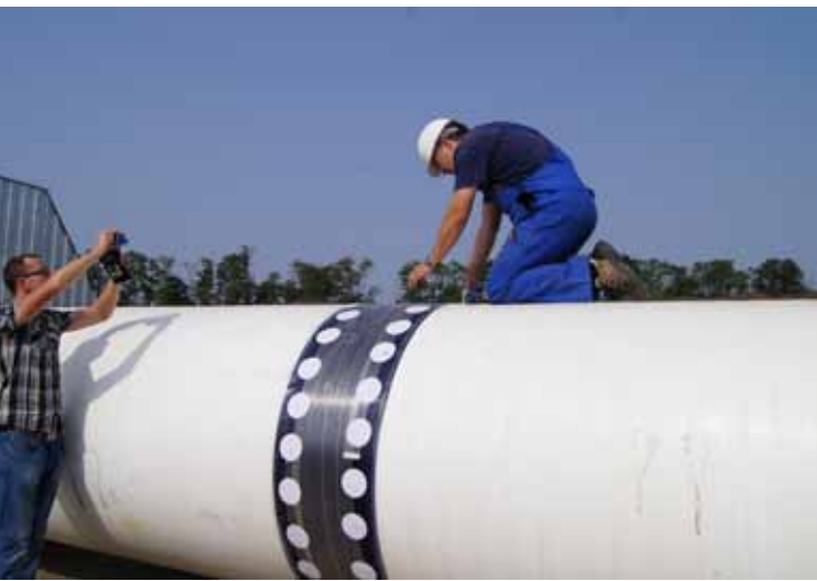
Слева-направо: Демонтаж кожуха после затвердения покрытия DENSOLID HDD
