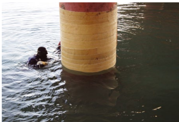
Рис. 9. Нанесение ленты на подводную часть сваи
