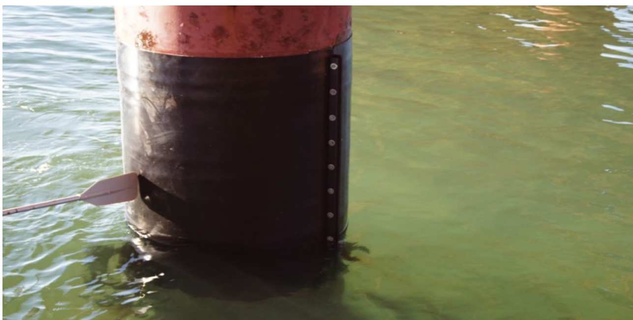
Рис. 11. Система MarineProtect®-2000FD после монтажа
