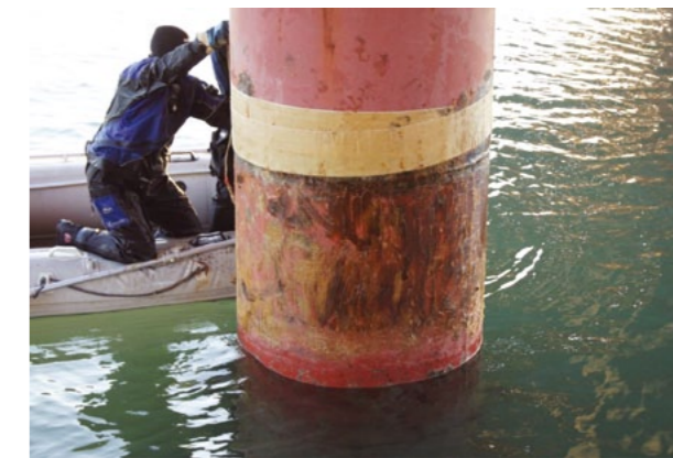
Рис. 8. Нанесение ленты на надводную часть сваи
