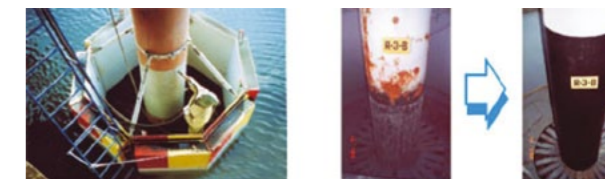
Рис. 3. Ремонт свай с использованием кессонов
