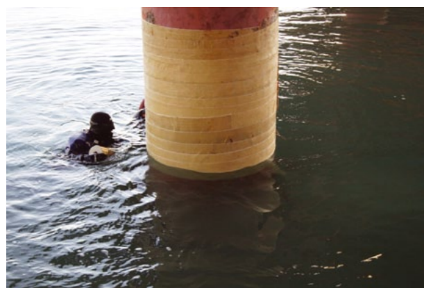
Рис. 9. Нанесение ленты на подводную часть сваи
