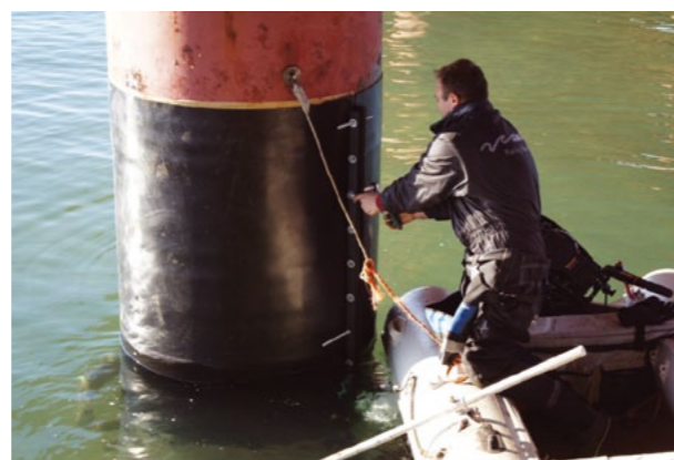
Рис. 10. Установка кожуха
