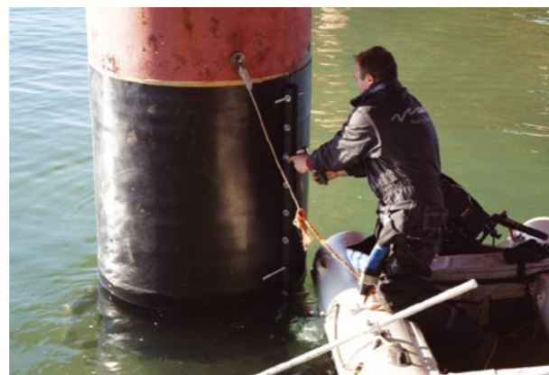
Рис. 10. Установка кожуха
